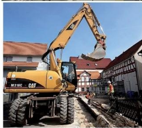
Ein Blick in das Innenleben der Energiezentrale der Genossenschaft Nahwärme Schönstadt. Links: In nur sechs Monaten Bauzeit wurden 2012 die 13 Kilometer Leitungen verlegt.
